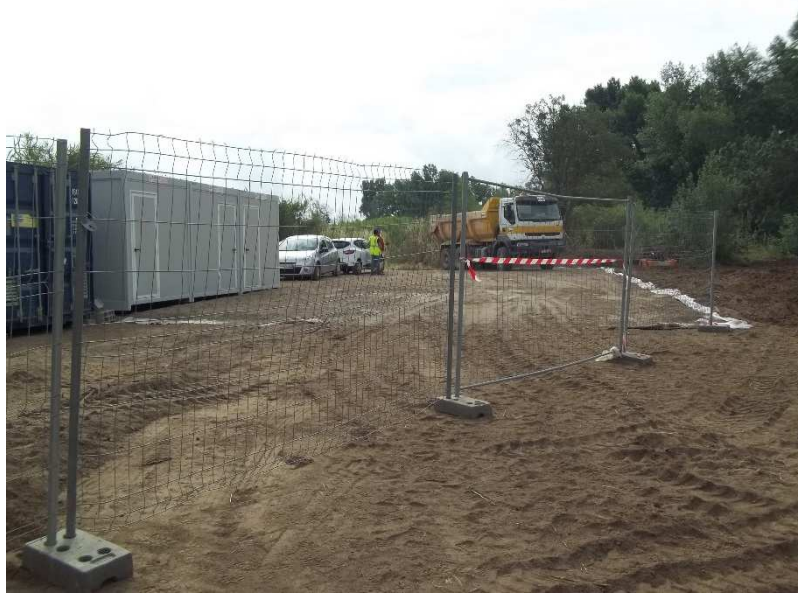
Aire de chantier protégée, balisée
